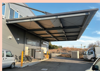
軒下が10mあるので降雨時やウィング車でも楽に積み込みが可能
