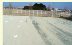
施工状況 (左:ソイレックス混合土) (右:緑色クリーニング)
