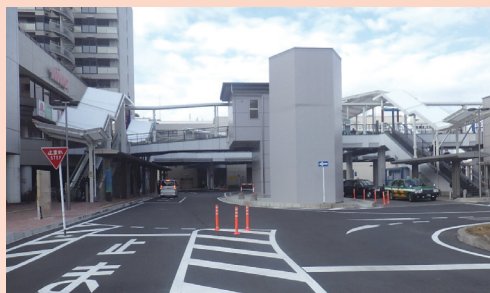
川越市東口の大型外構工事
