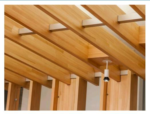
複数の板状の**支柱**と、それら**支柱の間に架け渡される梁**と、それら支柱と梁の間隔を空けて固定する**連結部材**と、を備えた柱と梁の連結構造
