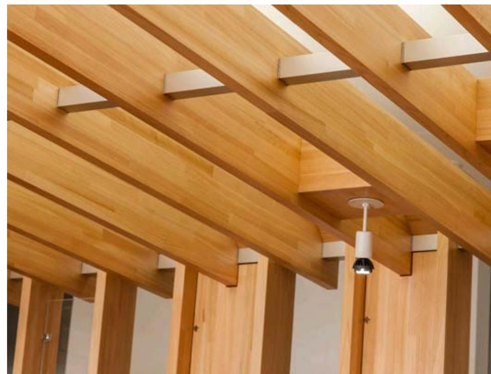
複数の板状の**支柱**と、それら**支柱の間に架け渡される梁**と、それら支柱と梁の間隔を空けて固定する**連結部材**と、を備えた柱と梁の連結構造
