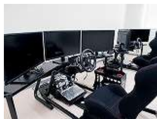
管制・遠隔運転室
