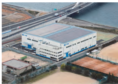
広島・航空エンジン・ガスタービン工場
