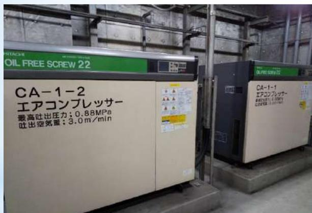
コンプレッサの更新を見据えて、現在の稼働状況の調査をした。電流変化を調べることで、稼働状況を把握。
